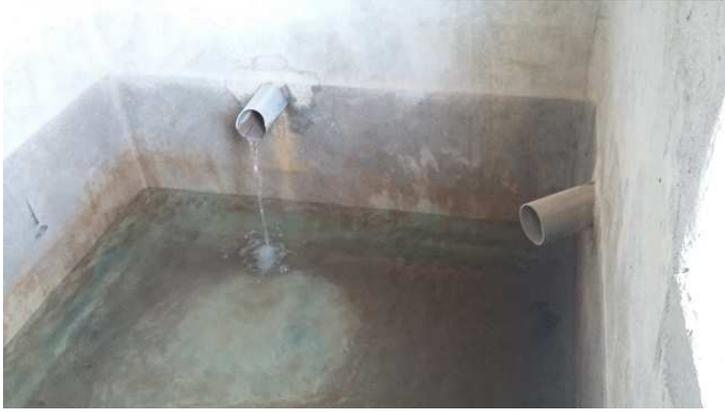
*photo 1 : arrivée des drains Nord et Sud-Est (pvc qui coule) et du drain Est-Sud-Est (sec) dans la bête de collecte*
