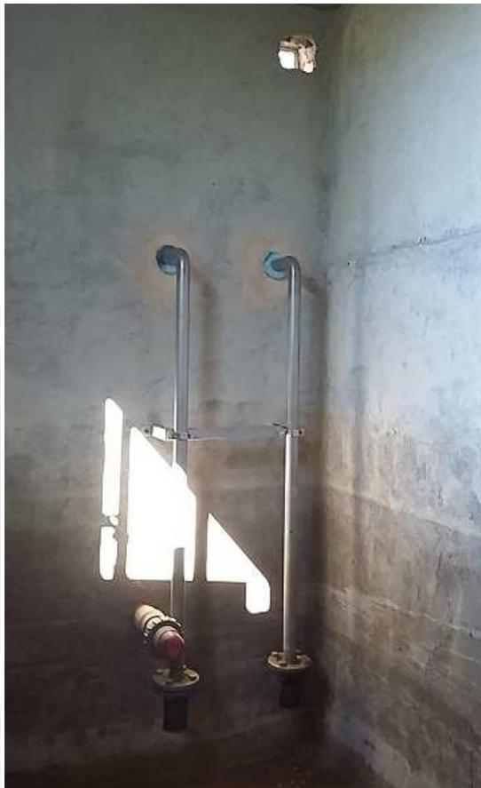
*photo 2 et 2 bis : trop plein et vidange (à gauche) ; double canalisation de pompage vers la chambre de traitement (à droite) à la bête de collecte. NB lors des manipulations du passage caméra, la bête a été vidée et nettoyée des fines*
